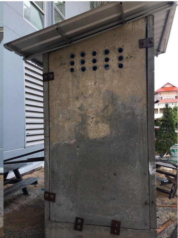
(ข) ห้องน้ำสำเร็จรูปด้านที่ 2
