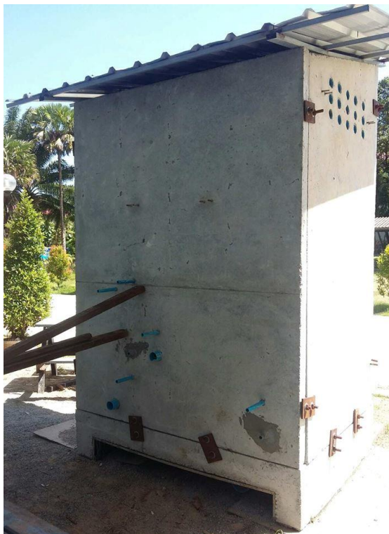
(ค) ห้องน้ำสำเร็จรูปด้านที่ 3
