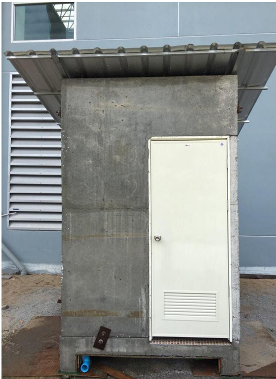
(ก) ห้องน้ำสำเร็จรูปด้านที่ 1
