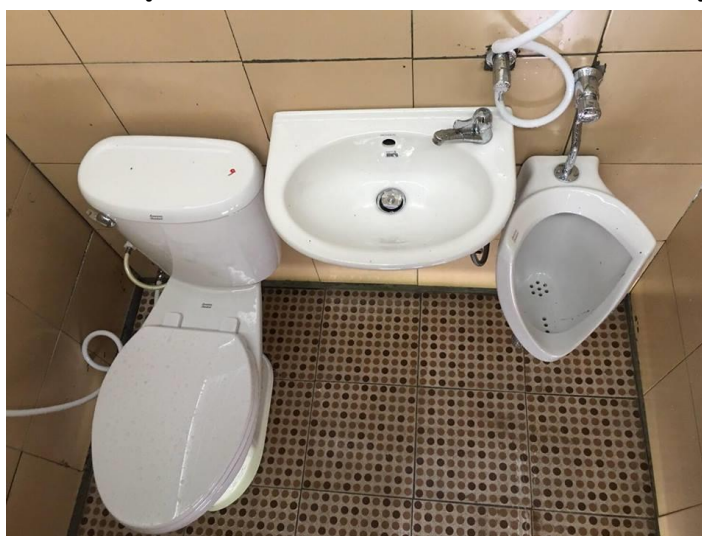
(จ) ภายในของห้องน้ำสำเร็จรูป รูปที่ 4.55 การประกอบและติดตั้งห้องน้ำสำเร็จรูป
