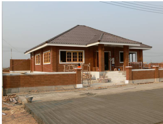
ภาพที่ 2-2 ตัวอย่างอาคารอิฐบล็อกประสาน (สถาบันวิจัยวิทยาศาสตร์และเทคโนโลยีแห่งประเทศไทย, 2556)
