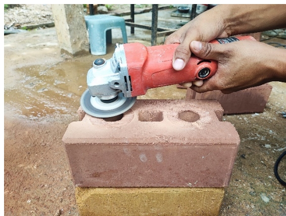
ภาพที่ 3-23 การตกแต่งอิฐบล็อกประสาน
