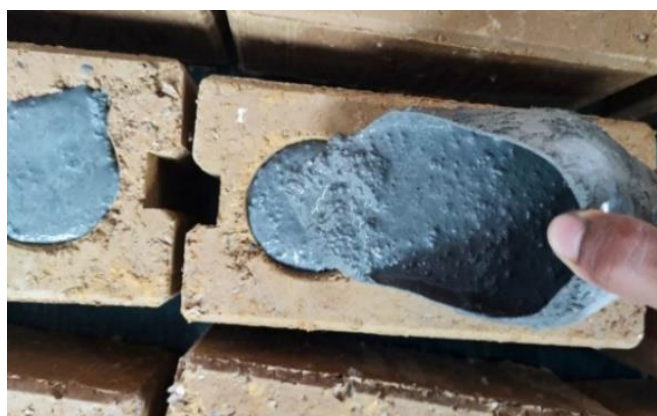
ภาพที่ 3.24 ปูนมอร์ตาร์หยอดที่รูอิฐบล็อกประสาน
