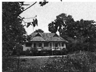
อาคารที่พักเดิม
