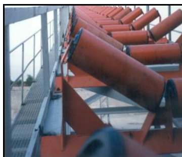
รูปที่ 2.28 ชุดโครงสร้าง (Structure) เป็นตัวรับน้ำหนักระบบสายพานลำเลียง [13]
