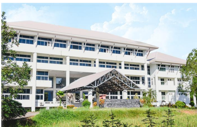
ภาพที่ 3.2 อาคารเรียนช่างอุตสาหกรรม แหล่งที่มา: https://cim.rmutsv.ac.th/ruts/
