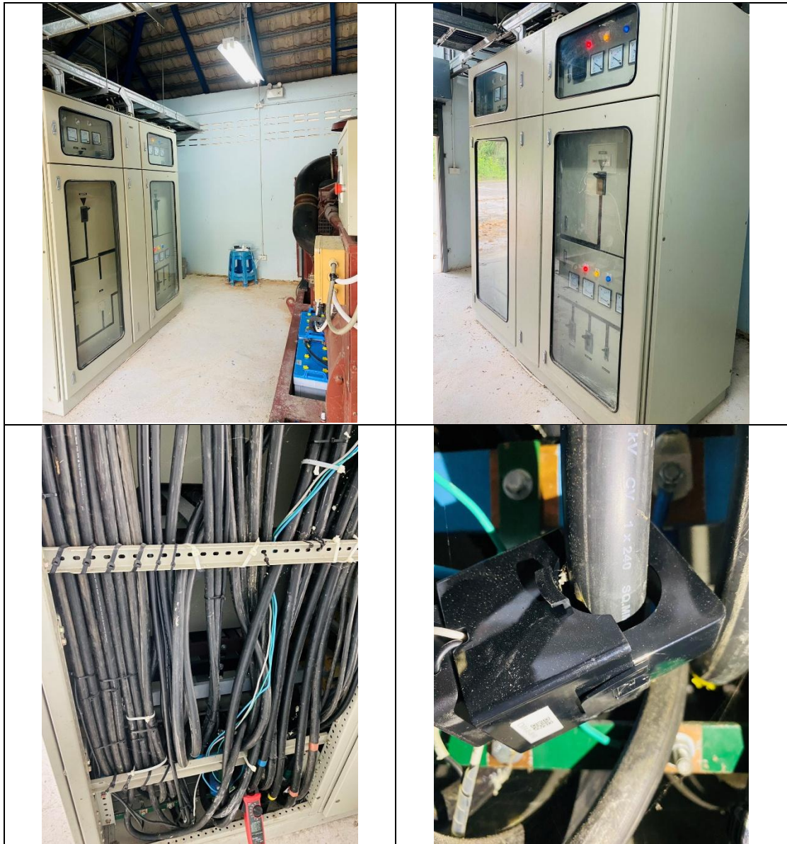
ภาคผนวก: ภาพการติดตั้งระบบตรวจวัดพลังงานแบบเรียลไทม์ภายในตู้ MDB ที่สายเมนหลักต่อไปยังอาคารเรียนช่างอุตสาหกรรม พร้อมการเปรียบเทียบความแม่นยำกับเครื่องมือวัดมาตรฐาน
